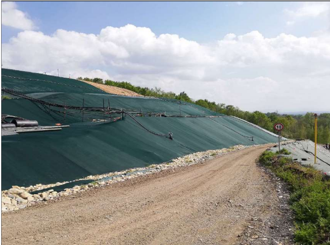
Figura 6: particolare settore ovest coperto con teli ldpe e rete antivento
