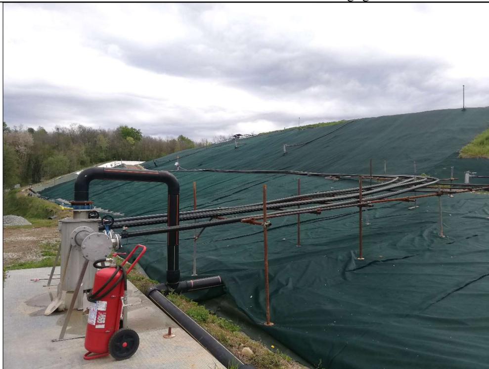
Figura 2: Sottostazione di regolazione nr. 2
