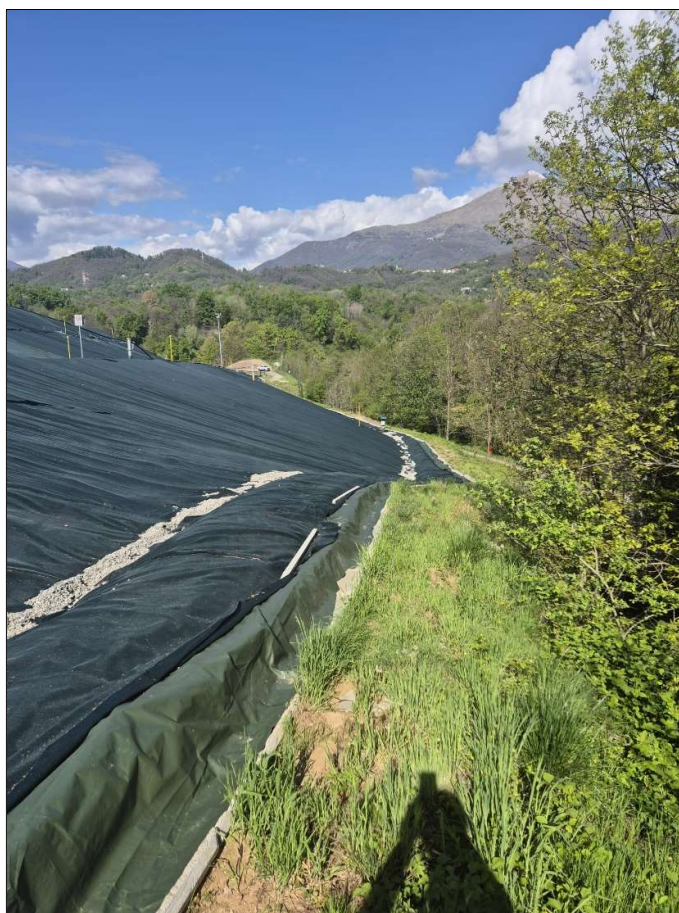
Figura 8: Settore Nord caratterizzato da copertura provvisoria
