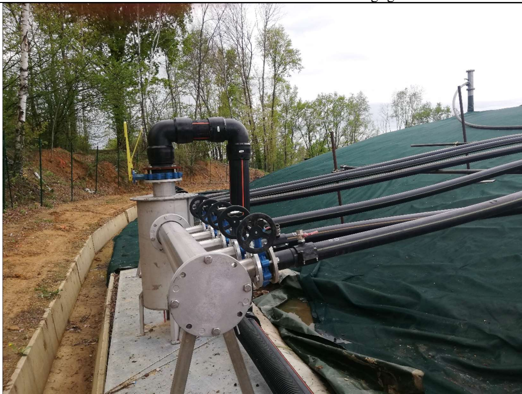
Figura 4: Sottostazione di regolazione nr. 4
