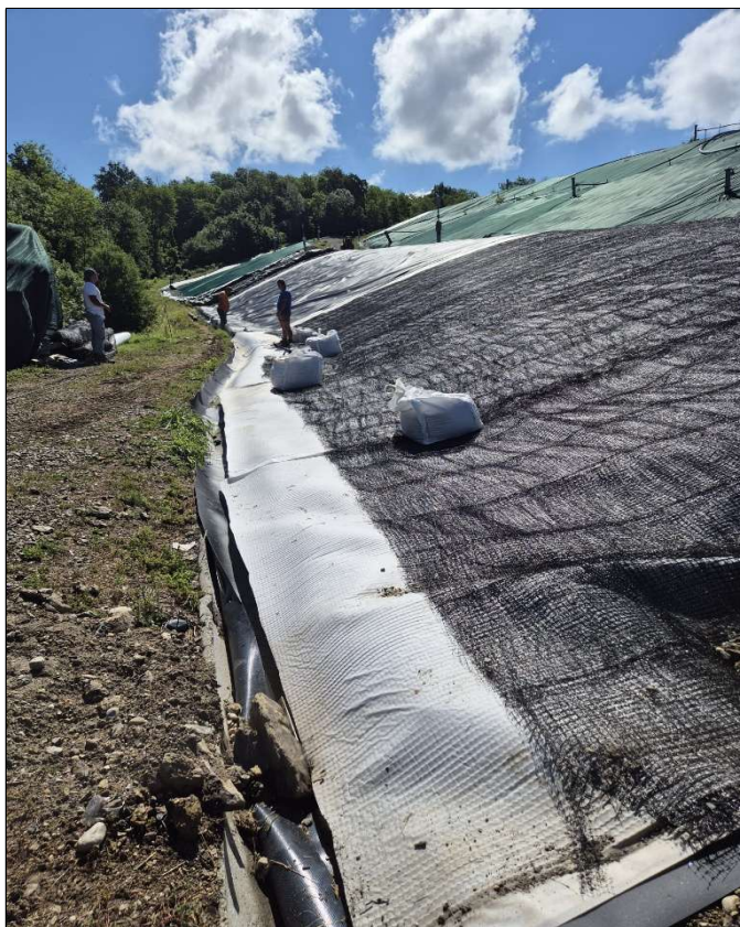
Figura 2: Posa dei materiali geosintetici
