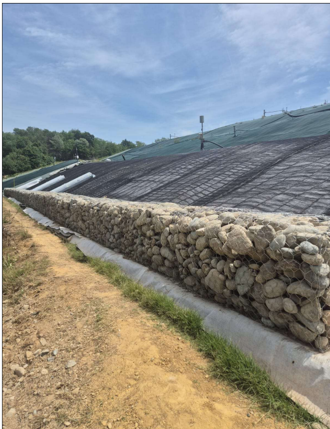
Figura 3: realizzazione gabbionatura al piede della sponda
