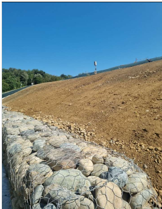
Figura 4: Posa strato terreno finale
